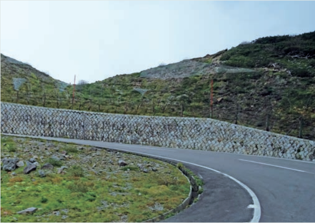
写真5 きれいに残るブロック積擁壁
