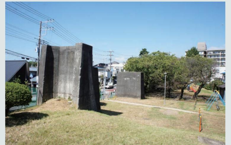
写真2 現存する鎌ヶ谷橋梁のコンクリート橋脚
