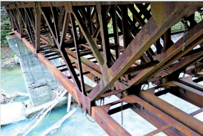
写真4 小巻沢林道橋のトラス構造とピン
