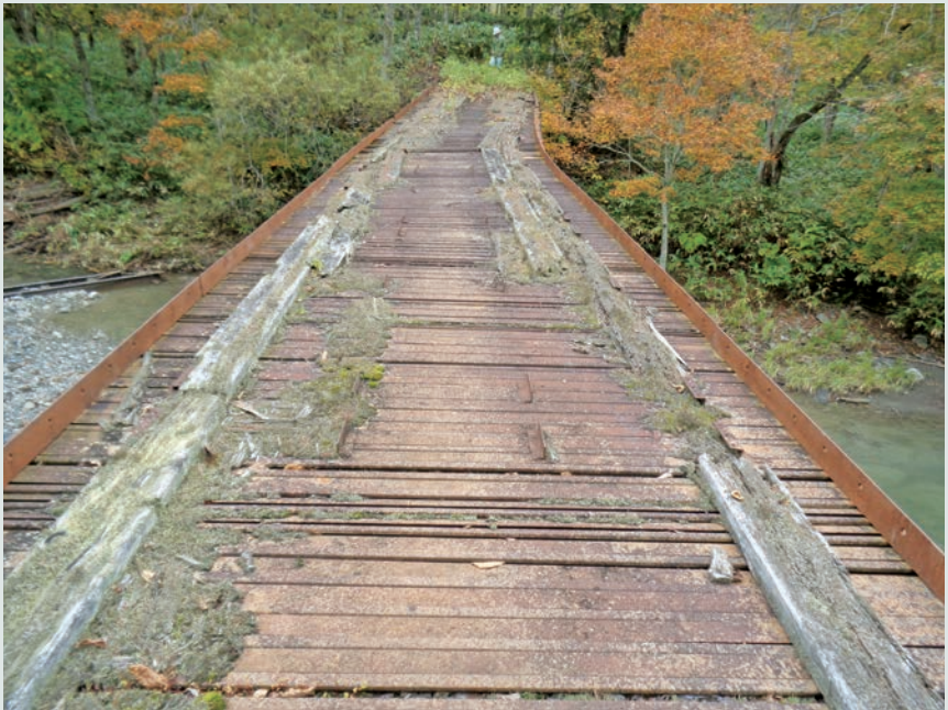
写真5 小巻沢林道橋上面
