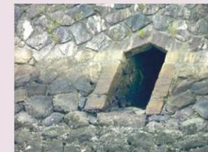
写真5 潮吹き防波堤の「穴（散水路）」
