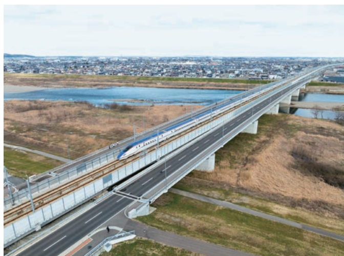
写真1 九頭竜川橋梁と新九頭竜橋
