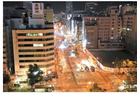
写真1 夜間施工の様子
