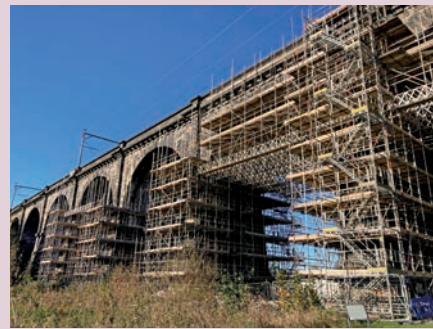
写真6 サンキー高架橋は修復のために足場が組まれていた
