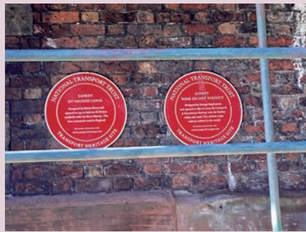
写真4 サンキー高架橋の橋脚に付けられたグレード1の看板
