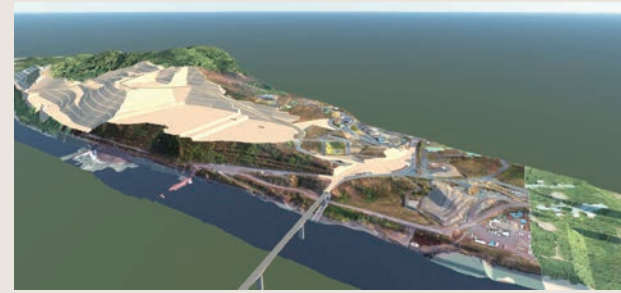
大河津山地掘削現況
