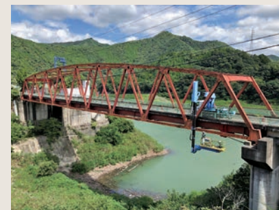
平橋点検状況
