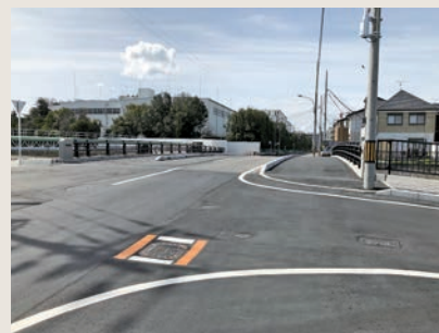
魁橋橋面全景
