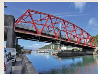
由良港橋点検状況
