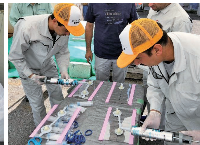
写真4 長崎大学でのひび割れ補修工法実習
