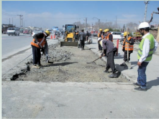
写真5 カブールでの舗装補修工事実習
