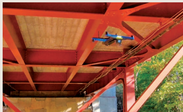
ドローンによる橋梁点検
