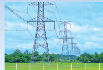
写真1 500kV架空送電線
