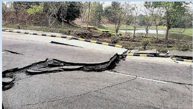
写真8 地震発生直後のネピドーの道路亀裂
