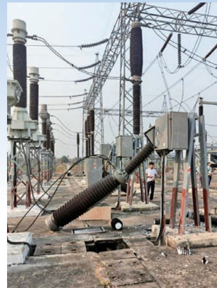
写真11 ネピドー既設230kV変電所ガス遮断機の破損
