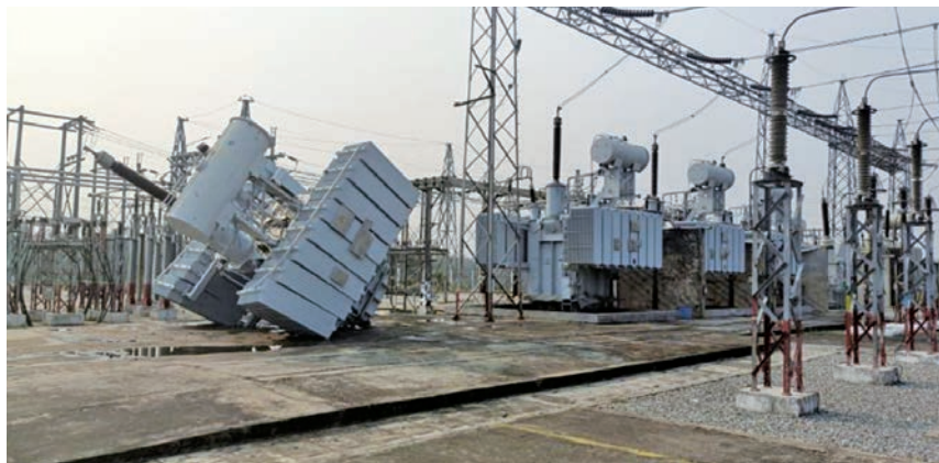
写真10 ネピドー既設230kV変電所 油注入前予備変圧器の転倒
