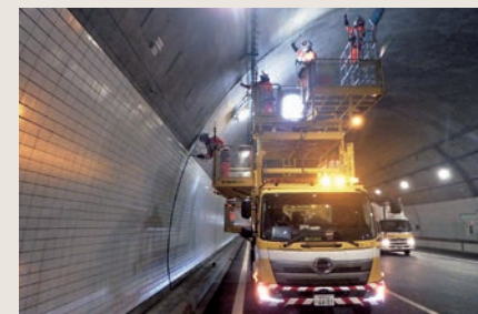
トンネル覆工コンクリート点検
