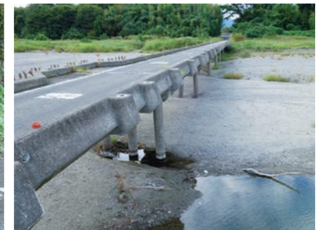
写真4 欄干のない潜水橋(大野島橋)
