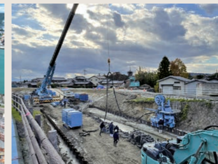
工事監督支援(河川)
