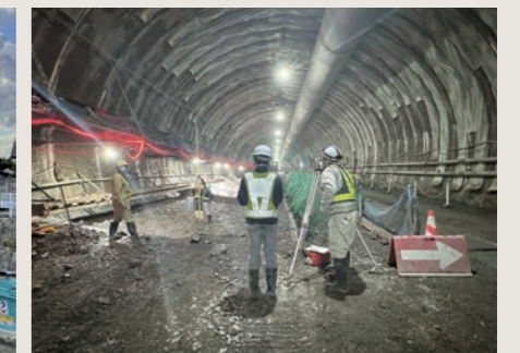
工事監督支援(道路)
