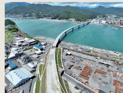
工事進捗管理(ドローン)
