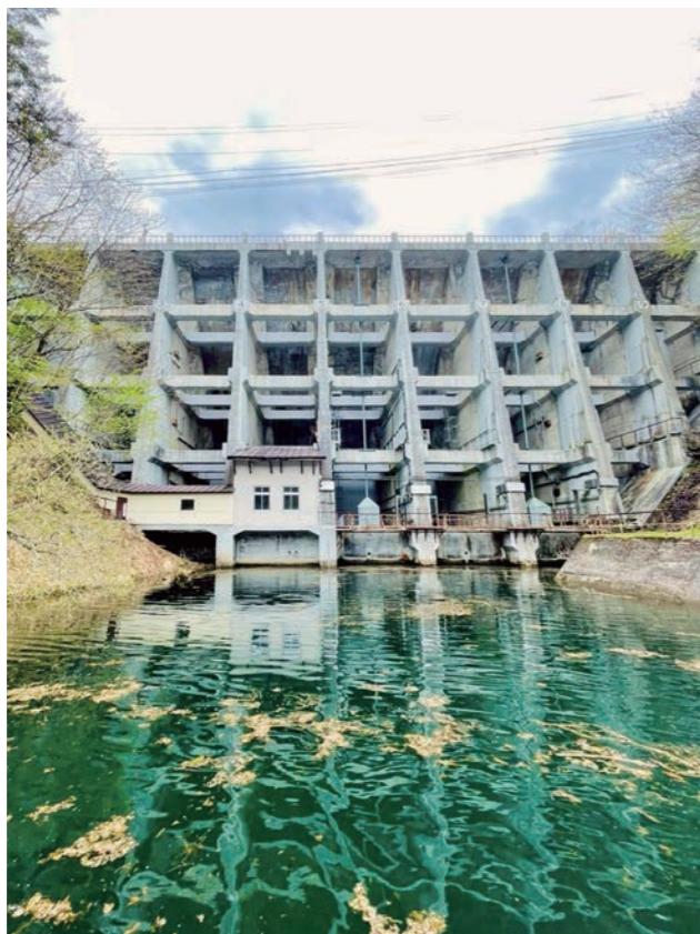
「バットレス式の傑作。丸沼ダム」
