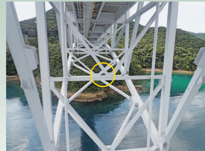
写真5 ドローンの点検状況（若松大橋）
