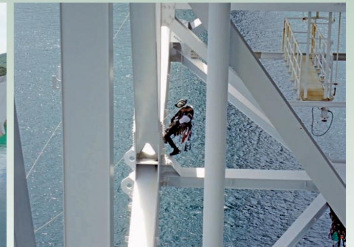
写真6 ロープによる点検状況（若松大橋）
