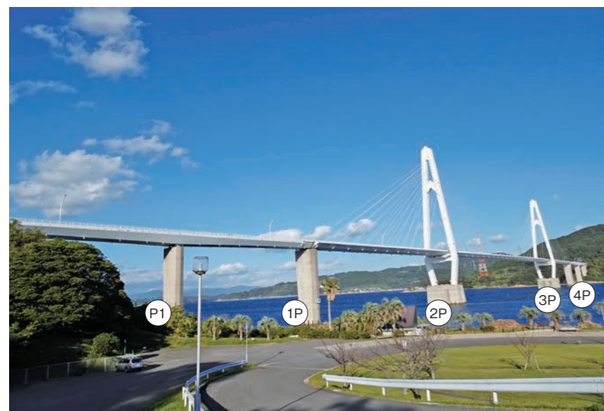
写真1 大島大橋全景
