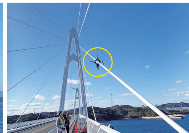
写真3 点検ロボットの点検状況（大島大橋）
