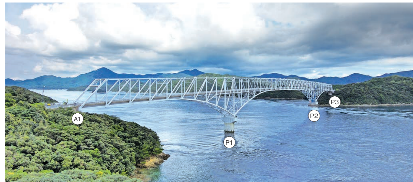
写真4 若松大橋全景
