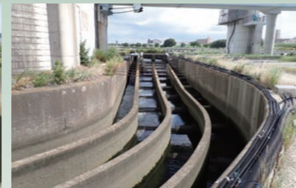
整備後(平成23年11月撮影)
