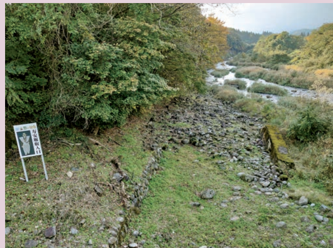
写真3 寿安堰取入口
