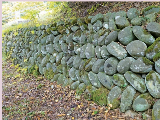
写真4 寿安堰石積工
