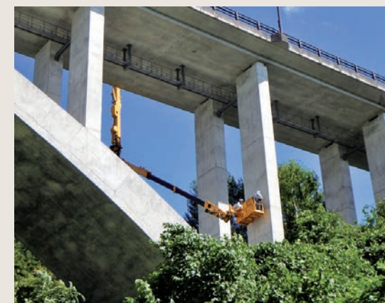
橋梁点検状況
