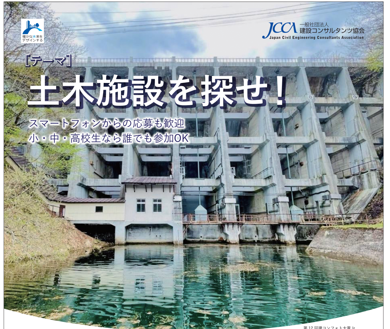
第12回建コンフォト大賞 Jr 最優秀賞「バットレス式の傑作。丸沼ダム」 （撮影地：群馬県利根郡片品村） 佐々木 夢叶（栃木県立栃木農業高等学校）
