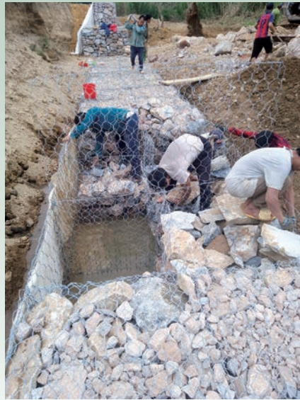
写真3 村人による河川護岸工事(ベトナム)
