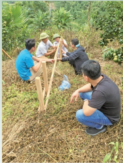
写真2 地すべりモニタリング丁張設置(ベトナム)
