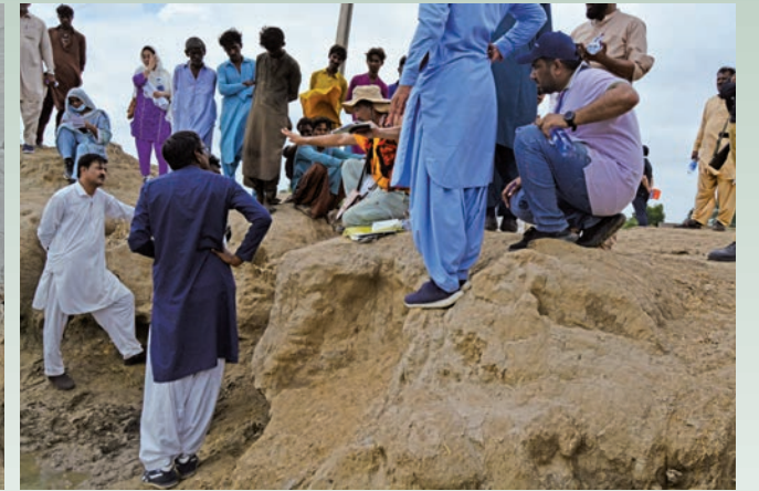
写真6 灌漑用水路の侵食調査(パキスタン)
