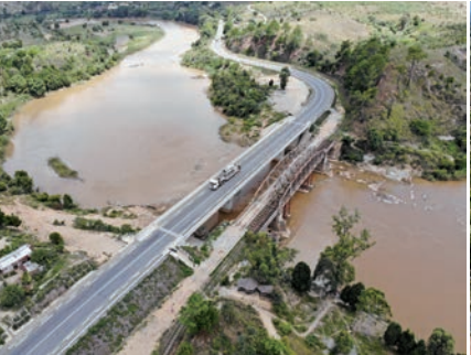
写真10 2橋梁利用状況(左:マンゲル橋 右:アンツァパザナ橋)
