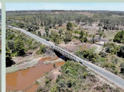
写真2 旧アンツァバザナ橋
