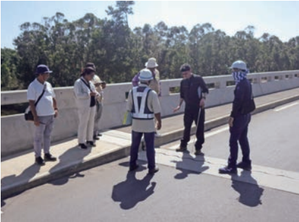
写真9 3者合同による瑕疵担保検査実施状況
