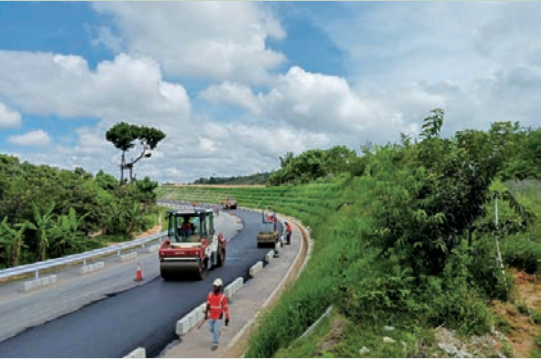
写真6 アスファルト舗装と法面保護
