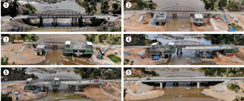
写真5 張出施工プロセス(マンゲル橋)
