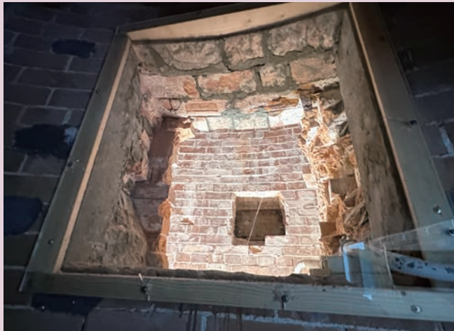
写真5 灯台内部のレンガ二重構造
