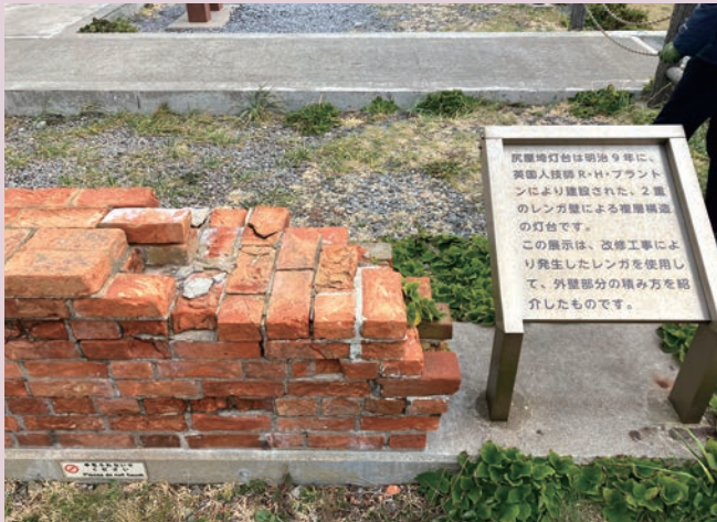
写真4 外壁部分のレンガの積み方
