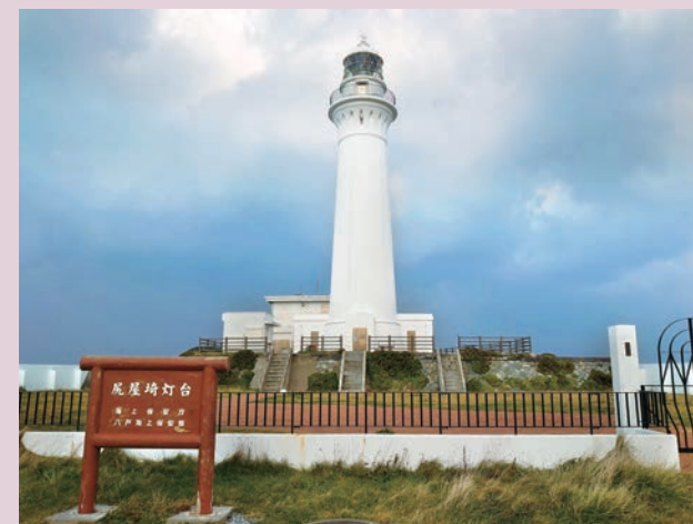
写真3 入口側から見た尻屋埼灯台
