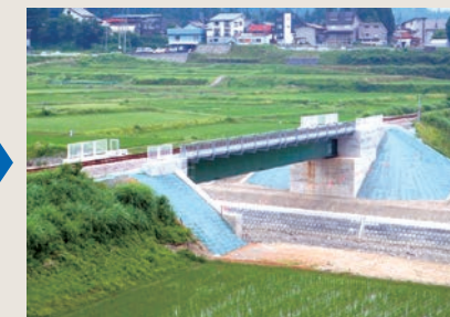
鉄道橋（復旧後）
