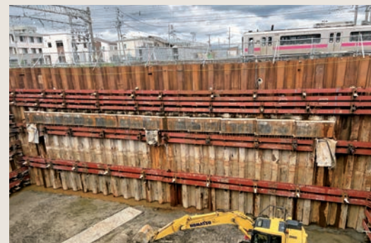
鉄道近接施工（仮土留め工）
