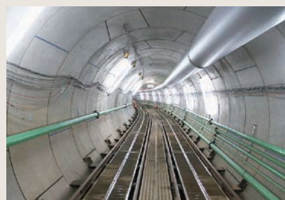
下水道（シールドトンネル）
