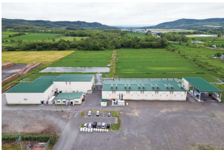
写真1 北の森発電所全景
