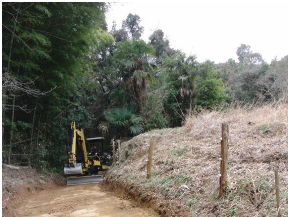
写真一2 進入路の整備
